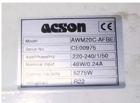
Figur 1: Mærkeplade inddel og mærkeplade uddel.
