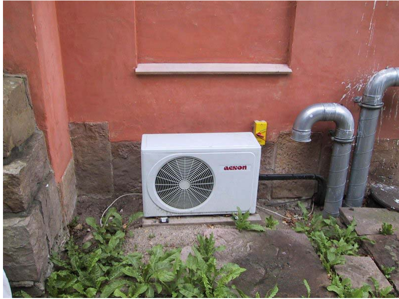
Figur 3. Køleanlæggets kondensator.
