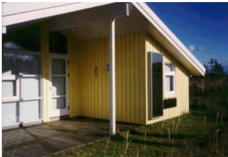
Fig. 3.1 Luftsolfanger og solcellepanel fra Aidt Miljø placeret på sommerhus.
