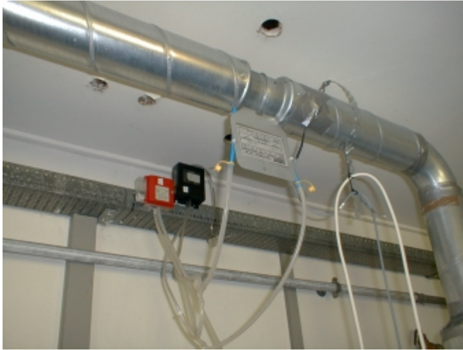
Figur 2.4. Målesystemets måleblænde og tryktransducere.
