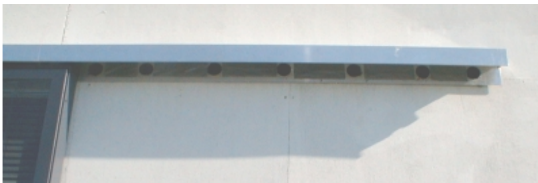
Figur 3.5. Bæreskinne med det profil, der danner overgang mellem væg og solskodde. Kun 30% af hullerne er åbne – se kapitel 4.
